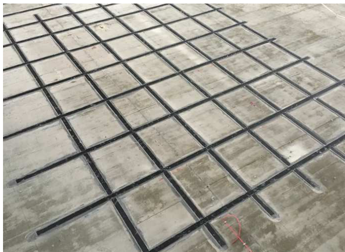
Slika 8: Križno lepljene lamele
